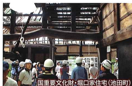
国重要文化財・堀口家住宅(池田町)
