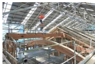
半解体中の土蔵
