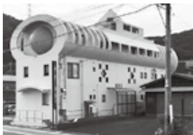
現在の全景(海に面した南側正面)
