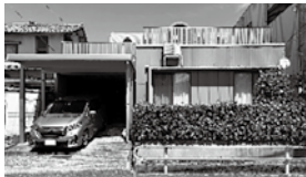
現在の建物全景(正面より)
