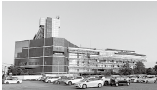
現在の建物全景(正面より)
