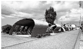
現在の建物全景(正面より)
