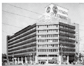
乾 馨 設計「織協ビル」 熊谷組 施工 1967
